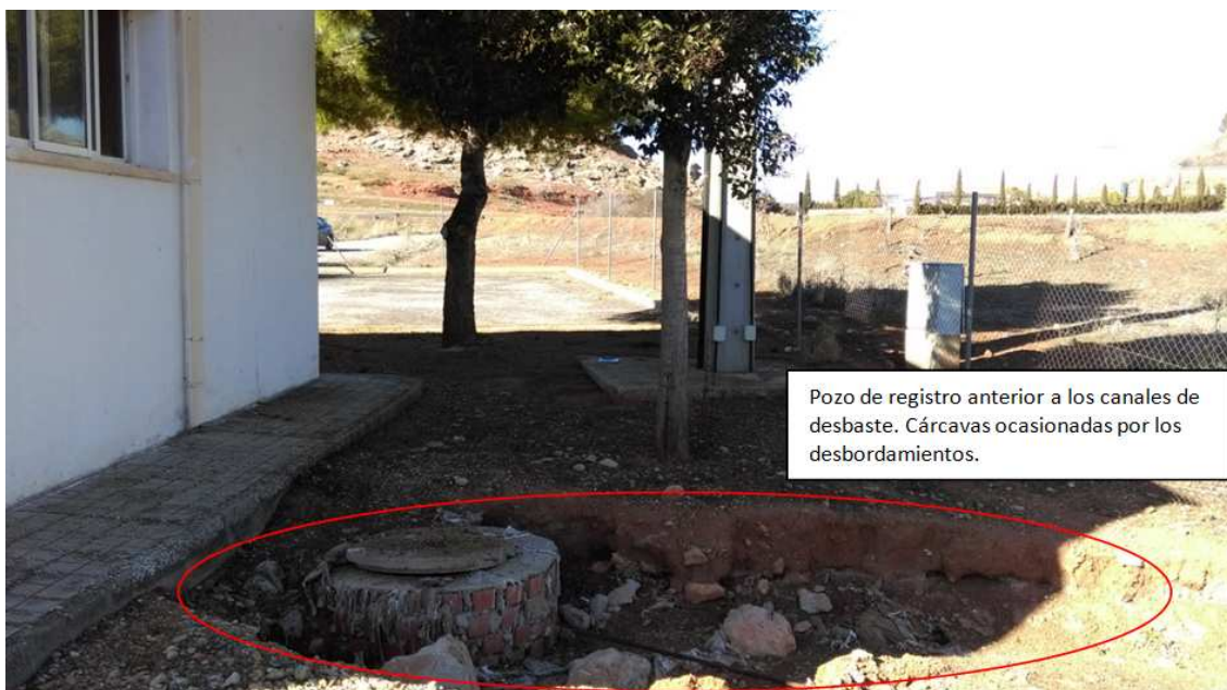
Imagen 9: EBAR de Almedina. Pozo de registro anterior al pretratamiento. Fuente: Elaboración propia
