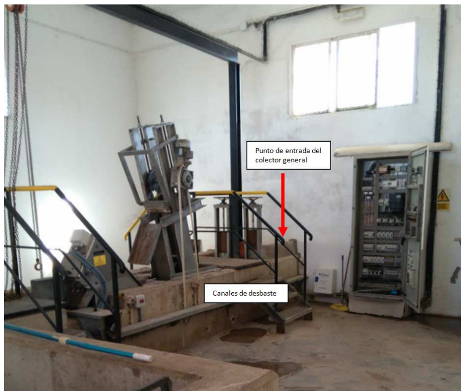
Imagen 4: EBAR de Villamanrique. Canales de desbaste. Fuente: Elaboración propia
