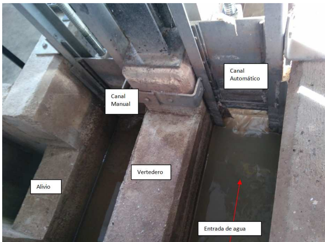
Imagen 11: EBAR de Almedina. Canales de desbaste y aliviaderos. Fuente: Elaboración propia
