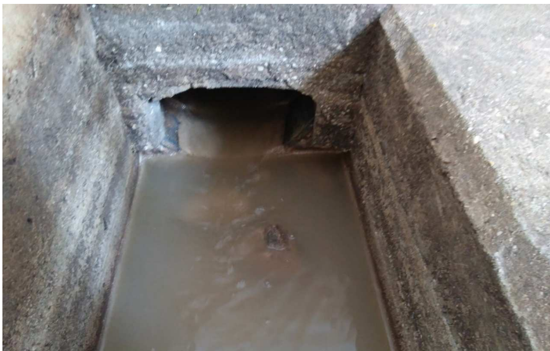
Imagen 10: EBAR de Almedina. Tubería de entrada seccionada. Fuente: Elaboración propia
